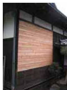
板張り補修完了時
