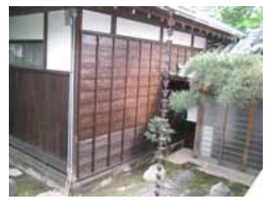
塗装後の完成状態
